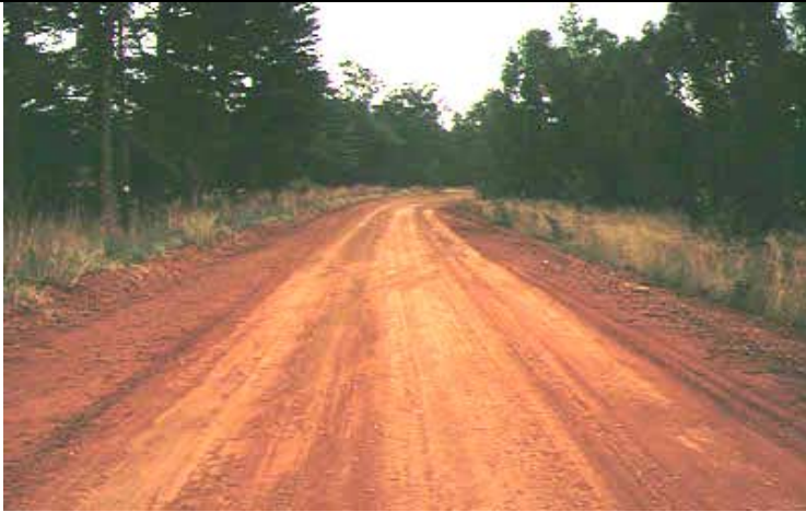
Longitudinal erosion
